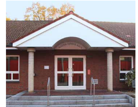
Eingang Gemeindehaus Schulweg
